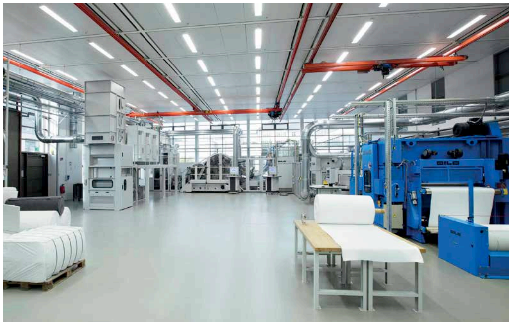
Die Stapelfaservernadelungslinie im Kompetenzzentrum Vliesstofftechnik
